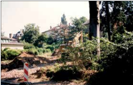
Das Grundstück Krausestraße 5 bei Baubeginn des Kindergartens
