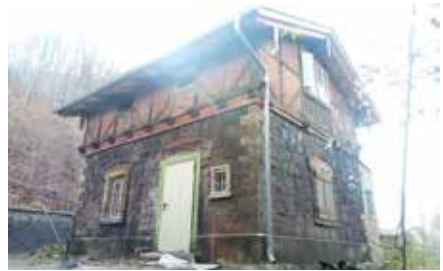
Hier wohnen jetzt Fledermäuse
