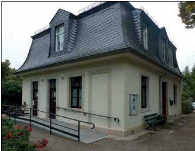
Saniertes Friedhofsmeisterhaus mit behindertengerechtem Toilettenzugang
