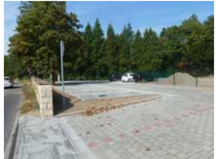
Blick über den Parkplatz
